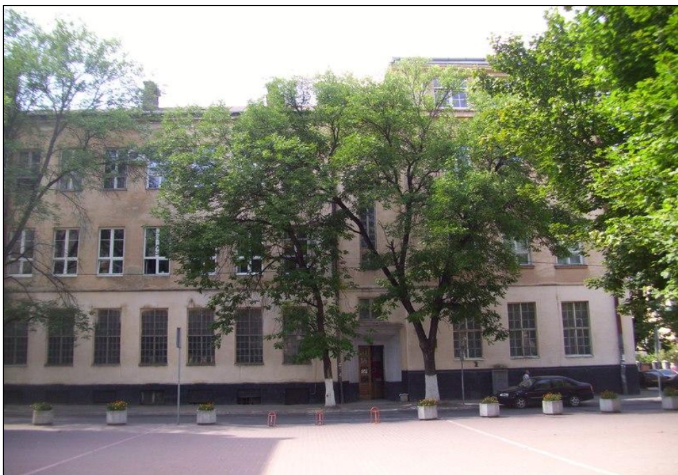
Іл. Б.12. Приміщення Львівської національної академії мистецтв, м. Львів, вул. Кубійовича 38
