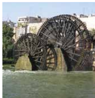
Рис. 227. Водяне колесо: а) схематичне зображення наливного колеса; б) сучасне використання підливного колеса для поливки; в) п'ятисотрічні підливні колеса на річці Оронт (Сірія)
