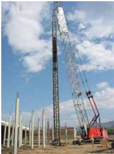
Рис. 222. Забивання палів під фундамент за допомогою будівельної машини — копра
