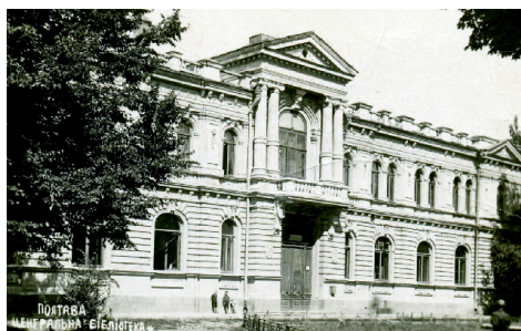
Центральная библиотека (бывшее здание Земельного банка)
