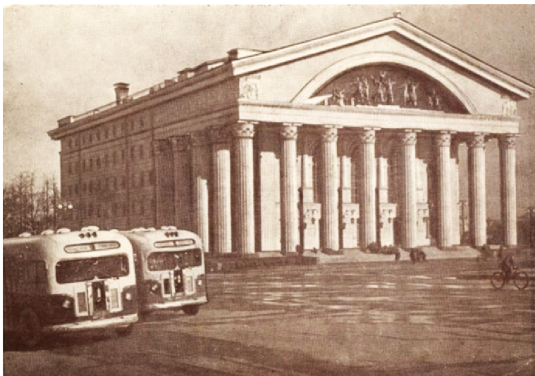
1957 г. Петрозаводск. Музыкально-драматический театр
